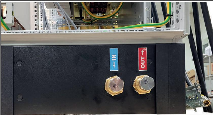
*Fig. 19 Conexiones para el agua.*
