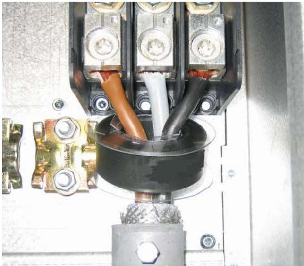
Fig. 55 Núcleo de ferrita instalado en los cables de motor
